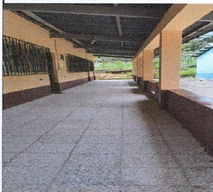
Foto 1: Mejoramiento y finalizacion de piso
