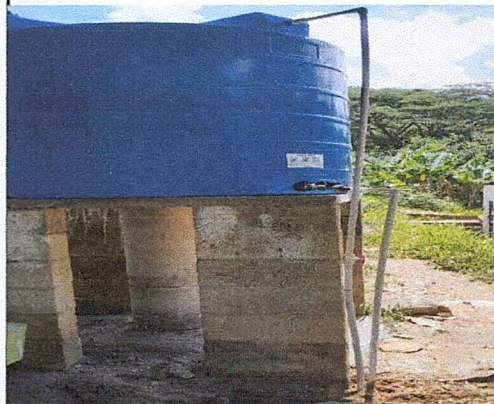
Foto 4: mejoramiento y finalizacion de sistema de agua, para sanitarios
