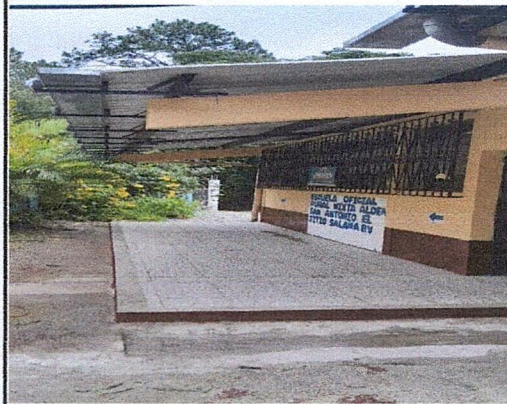
Foto 3: finalizacion de canales de agua
